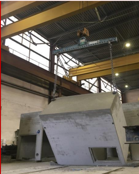
Neu gegossenes Trafohäuschen wird gedreht.,Foto: IG BAU
